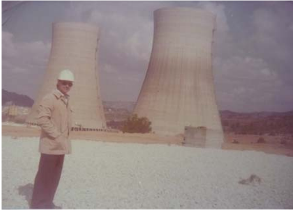
Central Nuclear de Cofrentes (Valencia). Torres de refrigeración. 1980
