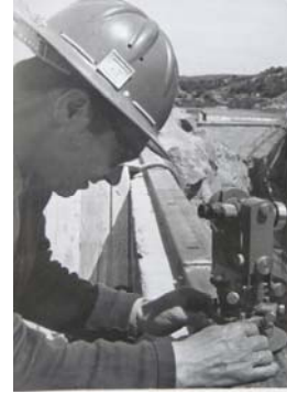
Presa de Azután (Toledo). 1969
