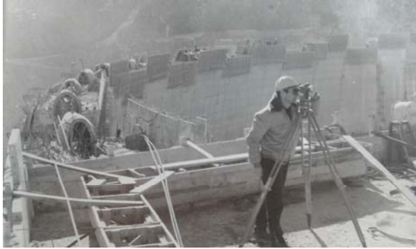
Presa de Valdecañas (Cáceres). 1962
