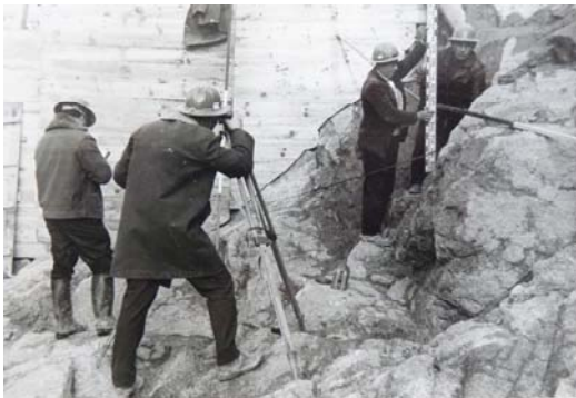
Presa de Azután (Toledo). 1967
