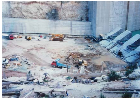
A.H. Cortes - La Muela (Valencia). Presa de Cortes II. 1984
