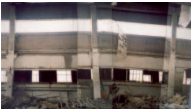
Fotografía 2. Una parte de la sección vertical longitudinal de la estructura
