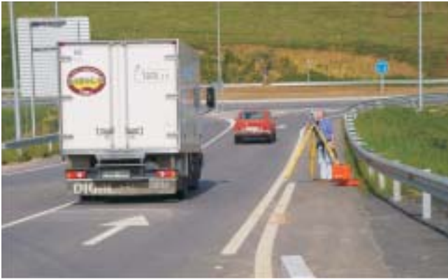
Topógrafo imprudentemente estacionado en el borde de una carretera
