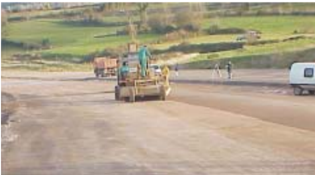
Equipo de Topografía replanteando en la fase final de la explanación
