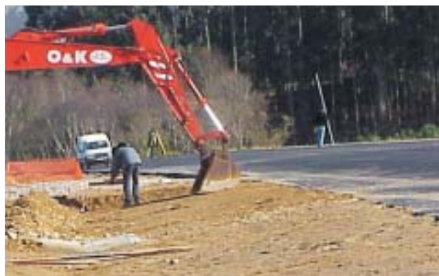
Equipo de Topografía replanteando el paquete de firmes
