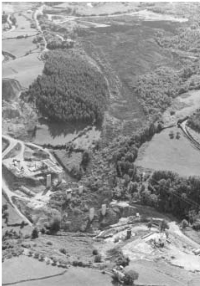
Deslizamiento de una ladera sobre las pilas de un viaducto
